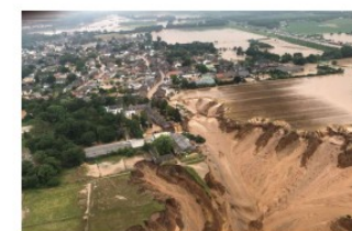
Glissement de terrain
