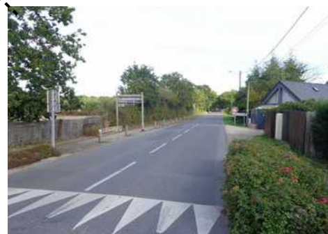
Voie piétonne reliant le village de Marlais
