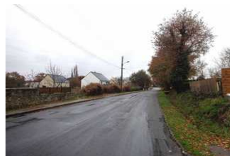
Voirie entre rural et urbain (fossé et trottoir)
