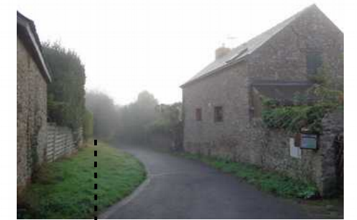
Bâti ancien mis en valeur par la conservation de ses abords
