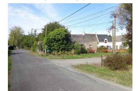
Hameau implanté en pignon sur rue
