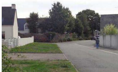
Manque de continuité dans le traitement des pieds de mur
