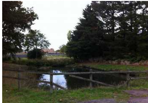
Plan d'eau gérant les eaux pluviales
