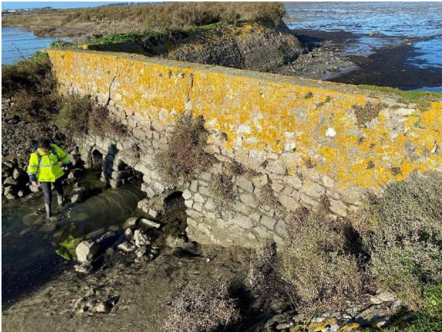
Figure 4-1 : Vue de l'ouvrage actuel de Bérigo
