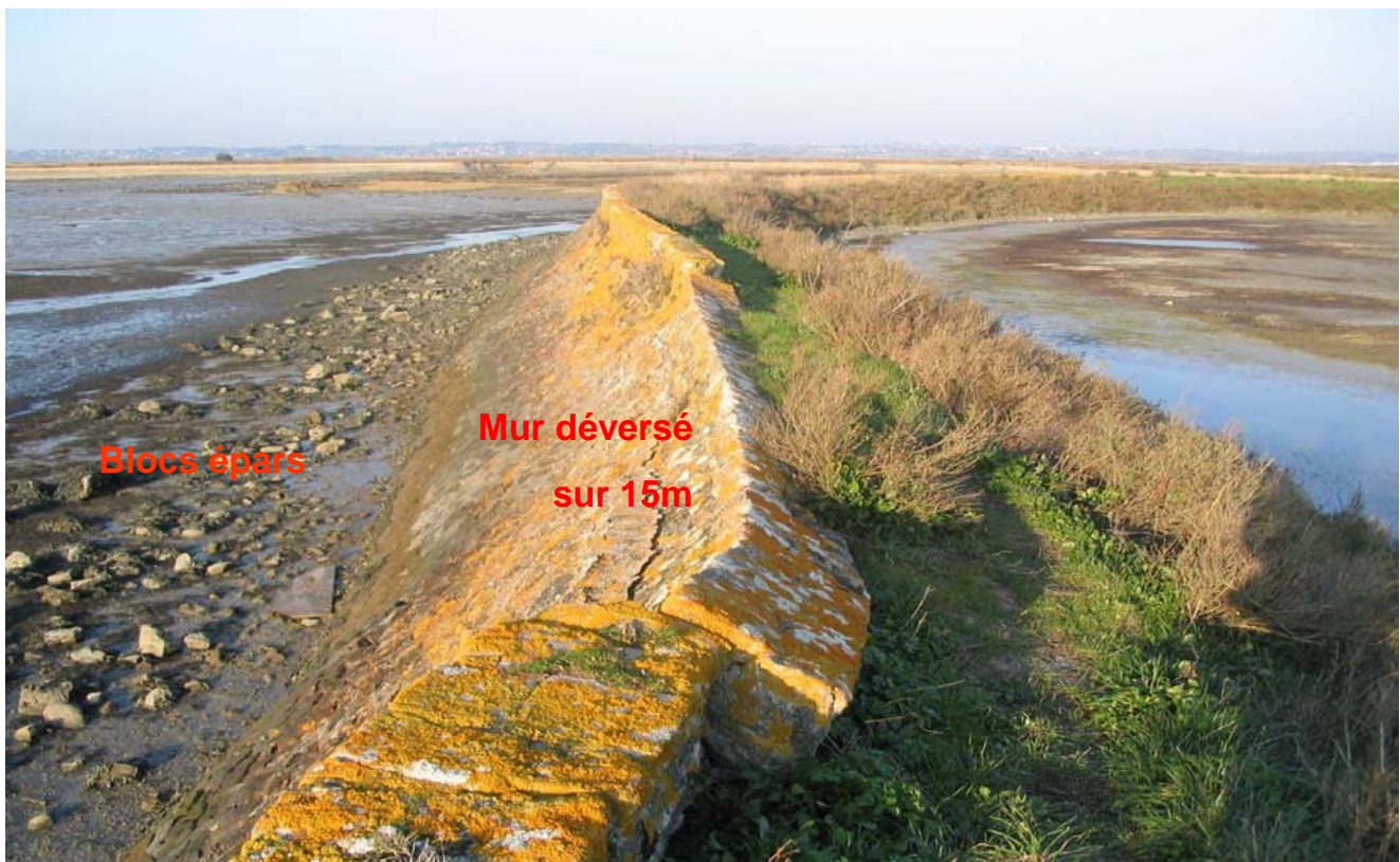
Photo 4 : Mur aval rive droite
