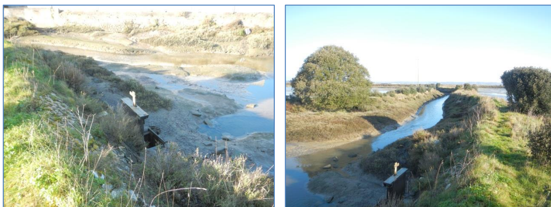
Fig. 25. Ouvrage d'alimentation de la vasière située à l'Est de l'étier
