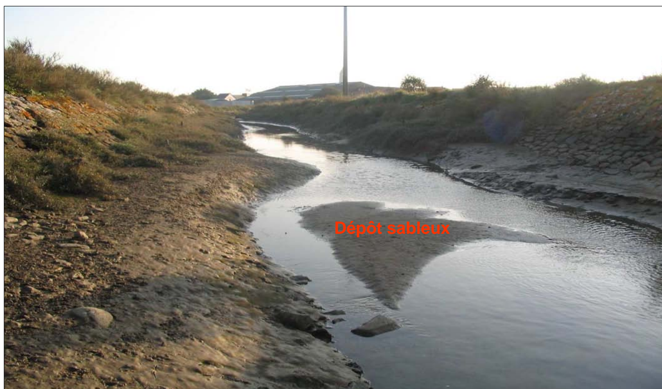
Photo 6 : Etier côté amont
