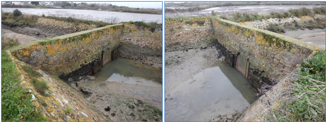
Fig. 15. Vue globale du parement aval de l'ouvrage de Bérigo (ARTELIA - 2016)
