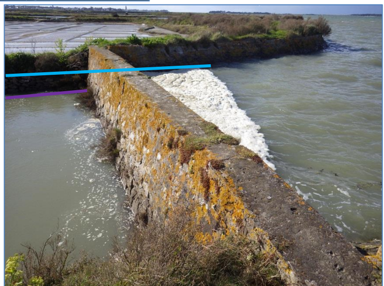
Fig. 24. Ouvrage de Bérigo lors d'une pleine mer (coefficient 115)
