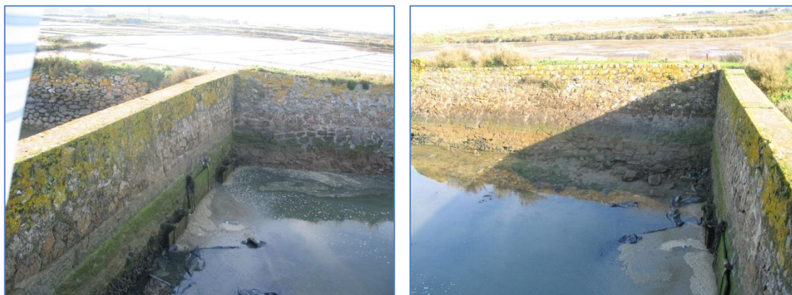
Fig. 3. Photos de l'ouvrage de Bérigo issus du diagnostic de 2008 (SOGREAH/ARTELIA – 2008)
