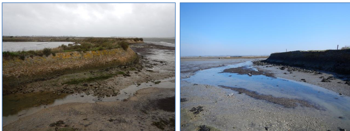
Fig. 21. Vue globale de la digue marine au droit de l'ouvrage de Bérigo (ARTELIA – 2016)
