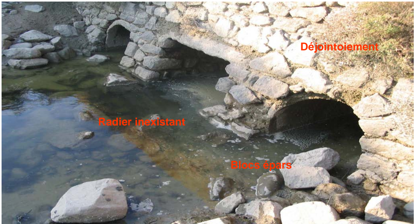
Photo 3 : Détail côté amont du barrage
