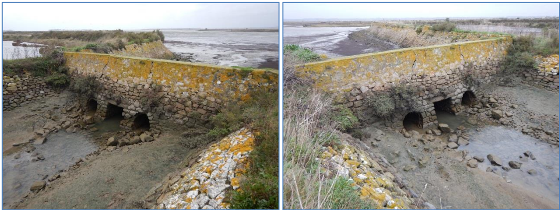
Fig. 8. Vue globale du parement amont de l'ouvrage de Bérigo (ARTELIA - 2016)
