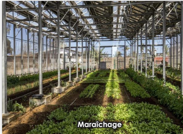
Serres photovoltaïques – Ile de la Réunion
