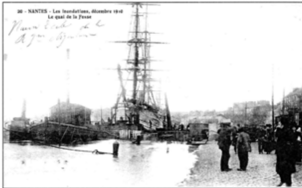
Nantes - Quai de la Fosse
