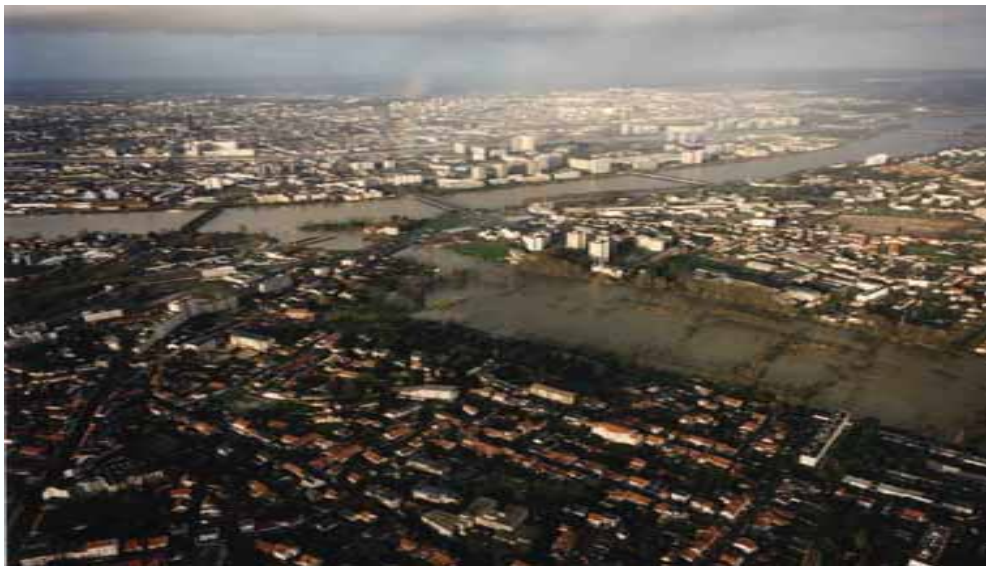
Confluence de la Sèvre – crue de janvier 1994
