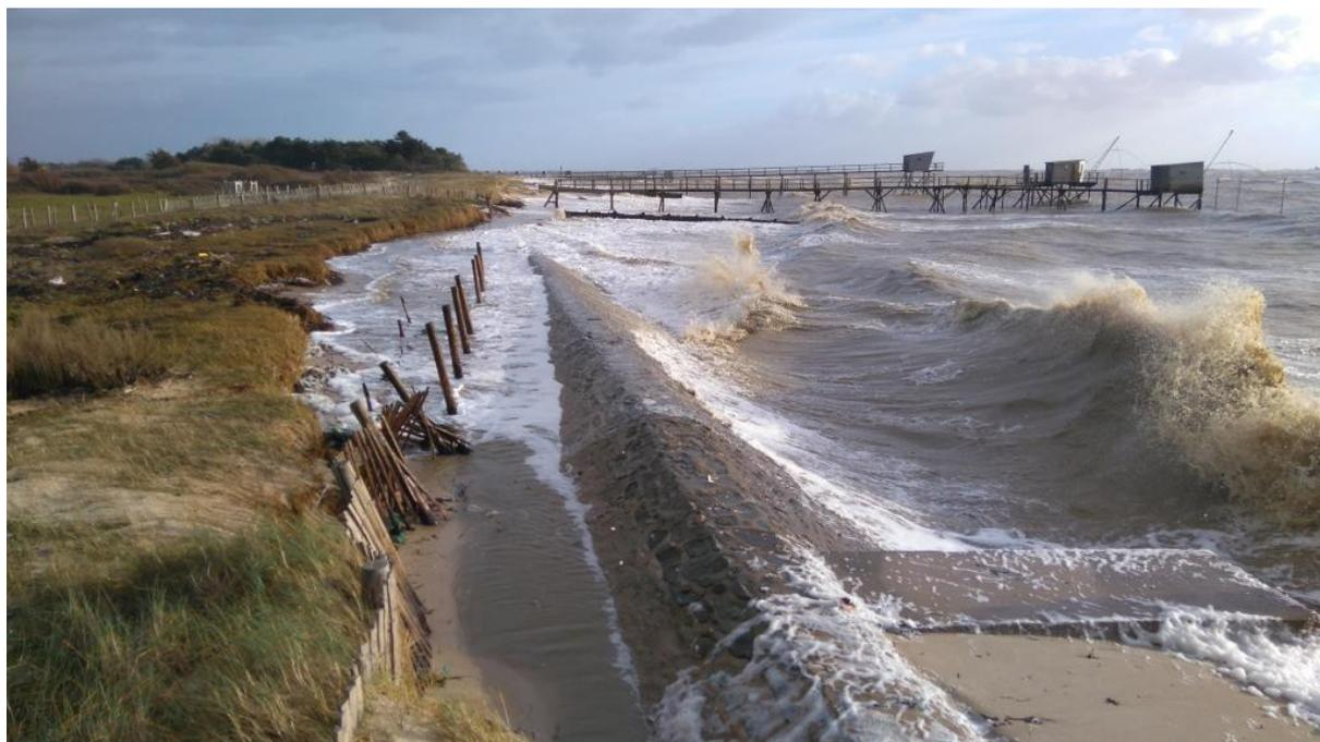
Figure 25 : Erosion du cordon dunaire par franchissement par-dessus la digue de Mainselle au Nord de la zone aquacole (Pornic Agglo Pays de Retz, épisode de tempête) le 9 mars 2016
