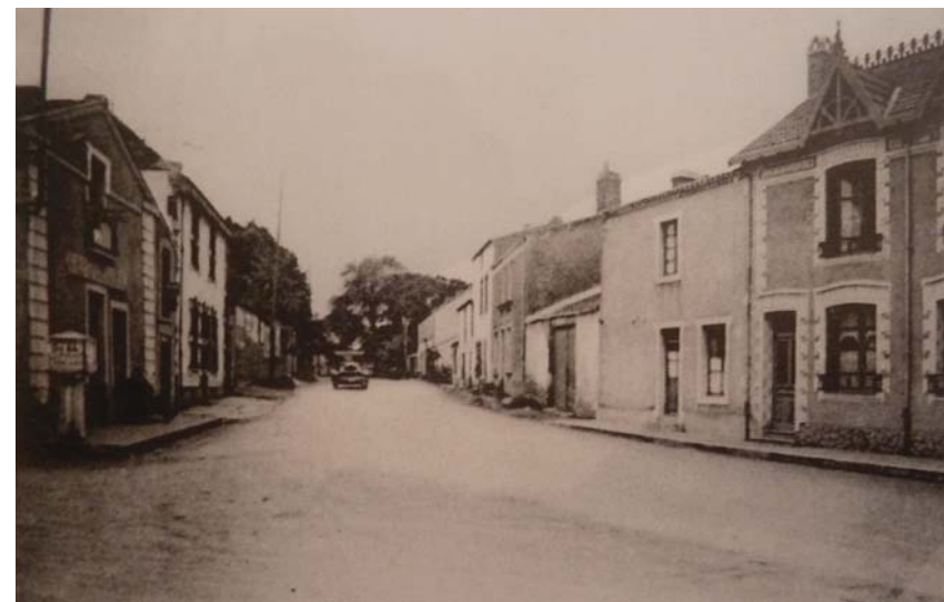
Photo n°16 : Le nouvel alignement dans la rue principale, avec l'une des seules maisons conservées (Source : Au coeur du Pays de Retz)
