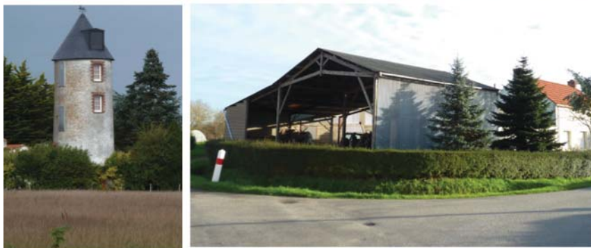
Photo n°5 : La présence forte de marque de l'agriculture (prises par le groupe Atelier les 11/10/13 et 14/01/14)
